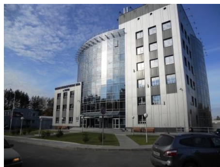
Foto: Bürogebäude in einem neuen Industriegebiet
